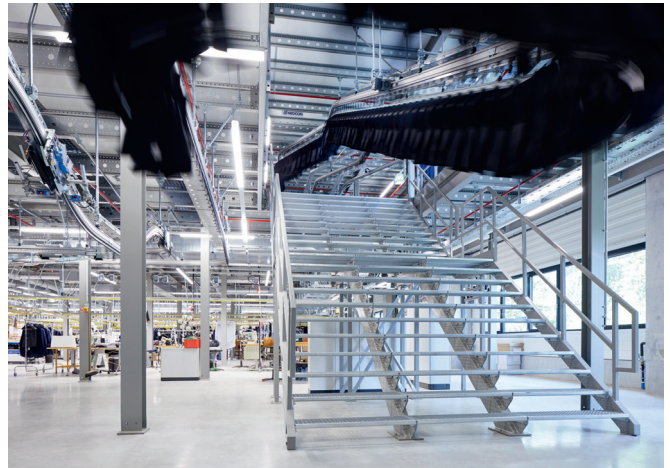
Die Fördertechnik des Warenlagers stammt von Dürkopp, die Stahlkonstruktion inklusive Treppe von Nedcon.
